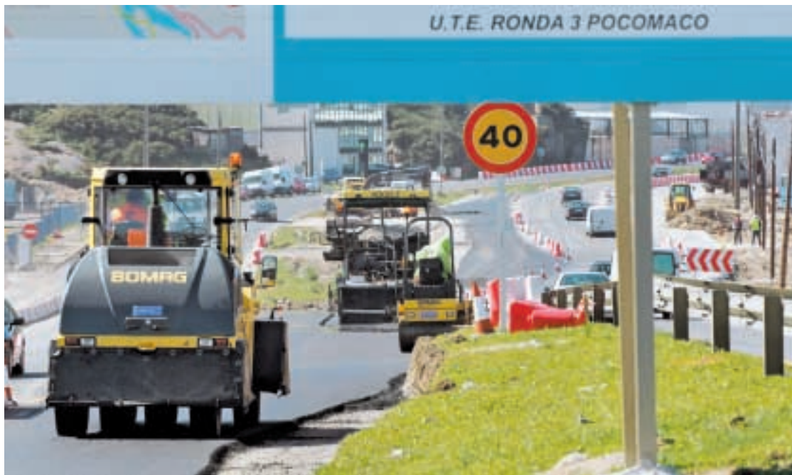
Las máquinas de la empresa concesionaria de las obras trabajan ya en la intersección de la tercera ronda con la carretera AC-552 | CÉSAR QUIJÁN
