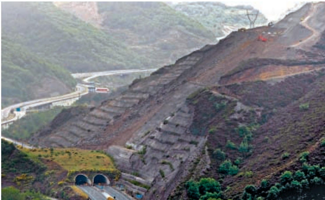
Las excavadoras —en la parte superior derecha de la imagen— trabajan en el desmante desde que en marzo se produjo el desprendimiento | ÓSCAR CELA
