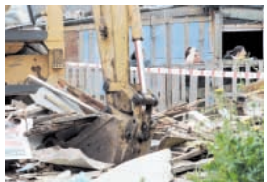
Una excavadora derriba una chabola ante tres vecinas | DIEGO VILLAR
