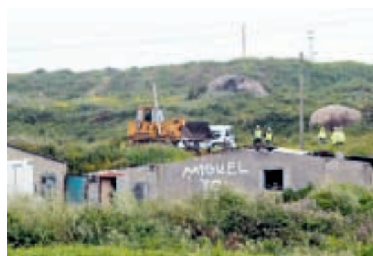
Una excavadora y varios trabajadores, ayer junto al poblado | OSCAR PARÍS
