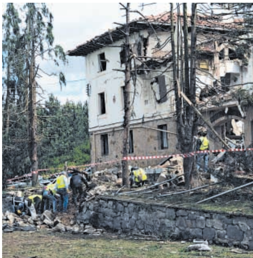
Agentes de la Guardia Civil buscan pruebas ante la casa cuartel, destruida por la explosión | A. ARRIZURIETA
