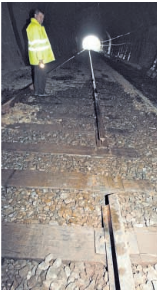
Imagen del corte en la vía férrea que ocasionó el descarrilamiento | PILI PROL
