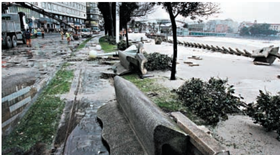
El fuerte oleaje desplazó los bancos de cemento del paseo marítimo corruñés, derribó parte de la balaustrada, farolas y árboles e inundó la calzada | KOPA
