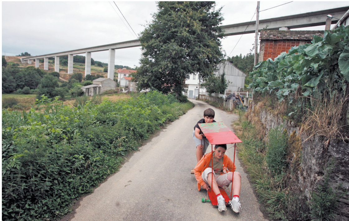
Las obras del AVE a su paso por Lalín acumulan retraso sobre los plazos inicialmente previstos
