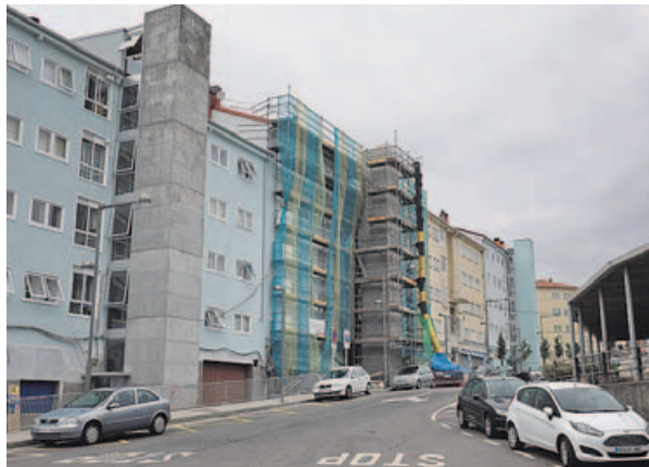
Instalación de ascensores en el ARI de Vista Alegre. FOTO X. A. SOLER
