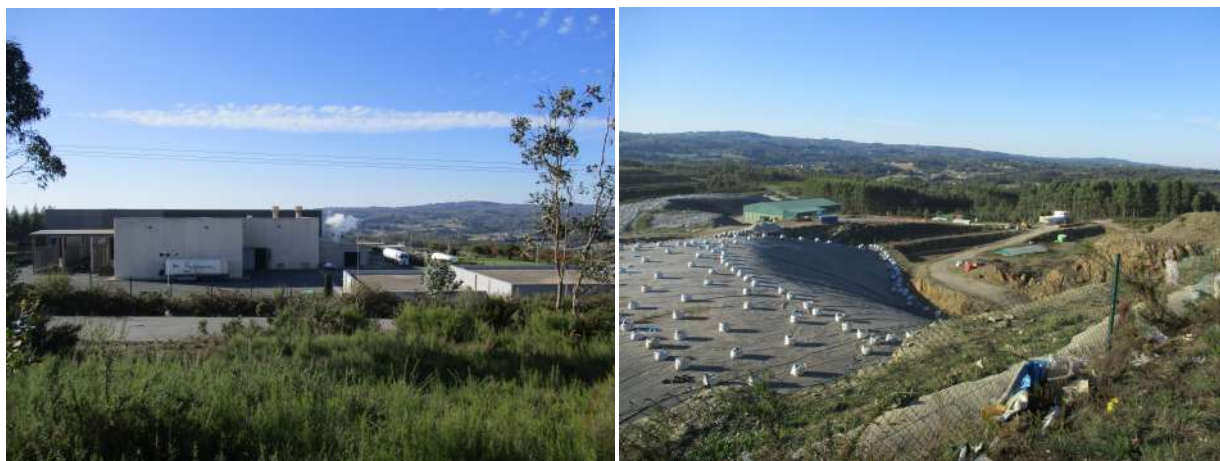
Vistas xerais dalgunhas das zonas de prospección alteradas pola presenza de instalacións industriais (vertedoiros e construcións asociadas).
