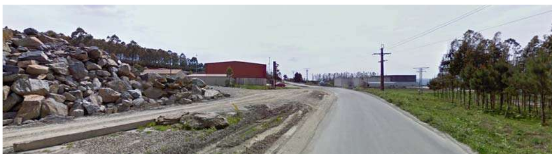
Area industrial con GESUGA e o ámbito da ampliación á dereita.
